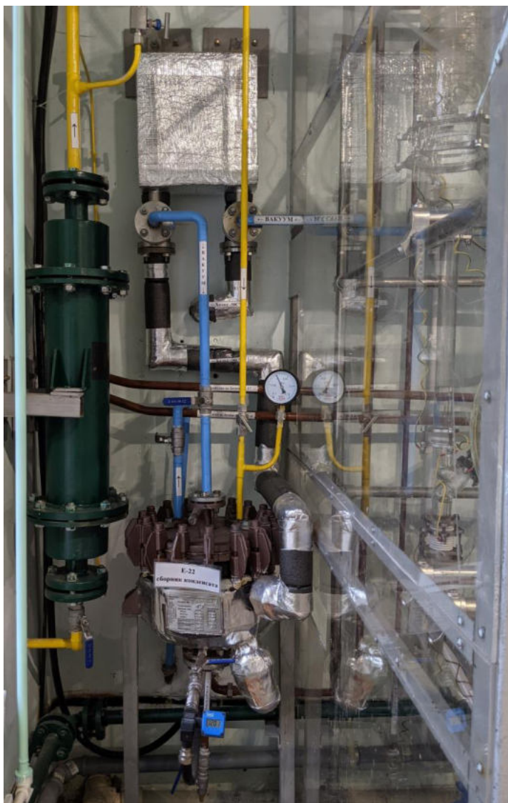
Рисунок 23 – Низкотемпературная (узел улавливания легколетучих соединений)
