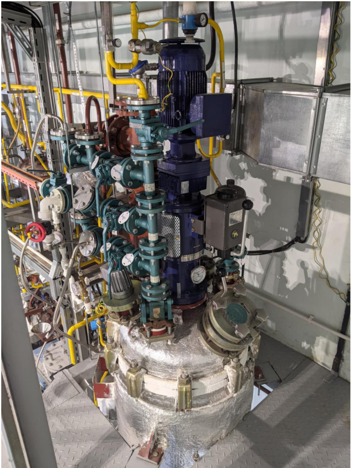
Рисунок 19 – Реактор синтеза V=216 л опытной установки и гребёнки для подвода реагентов
